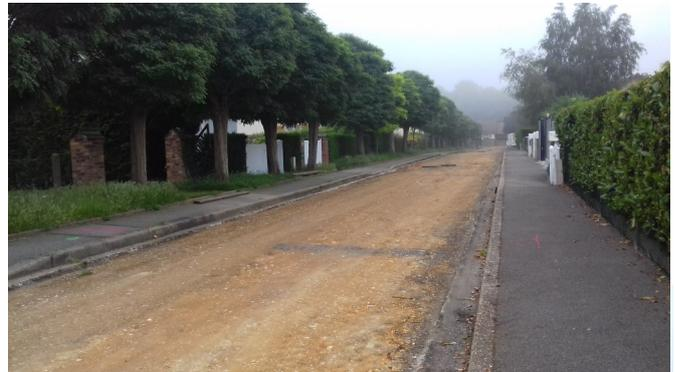
Pour la rue des Acacias, il a fallu revoir les niveaux de voiries car lors de fortes pluies, les eaux ne s'évacuaient pas normalement et stagnaient au fond du parking des acacias. La pose d'un caniveau canalisant les eaux vers l'allée des grands bois a donc été réalisée.
